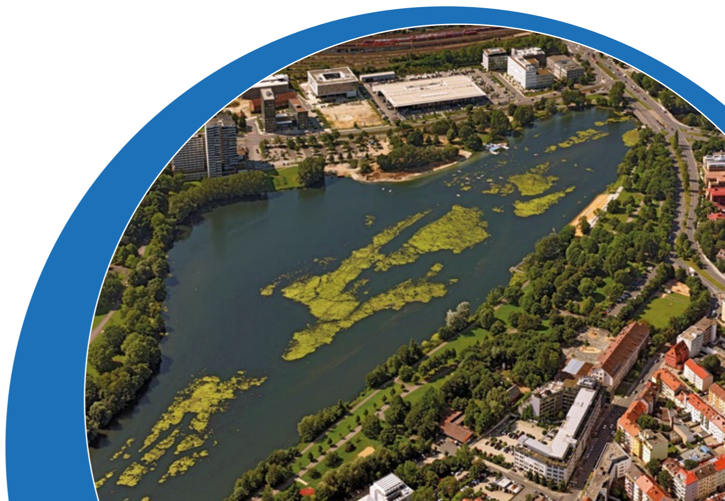
Innerhalb von rund 30 Jahren sammelten sich über 300 000 m 3 Schlamm an.
